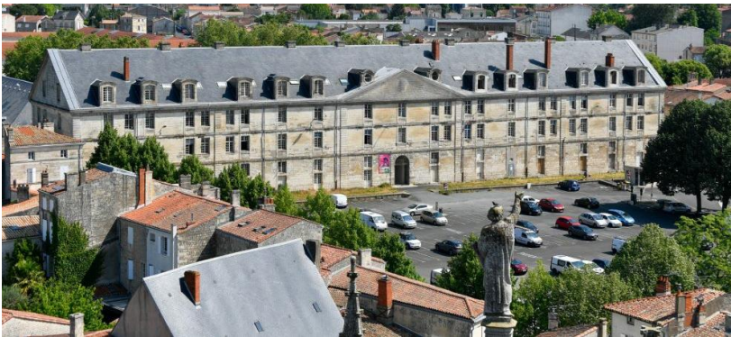
Bâtiments services municipaux
